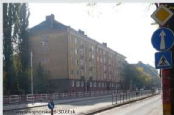
Foto: www.vajnorska-6-30.6f.sk Tehlový bytový dom, Nové mesto
